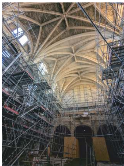
L'échafaudage pour la première tranche de la restauration de la nef est en cours de montage.
